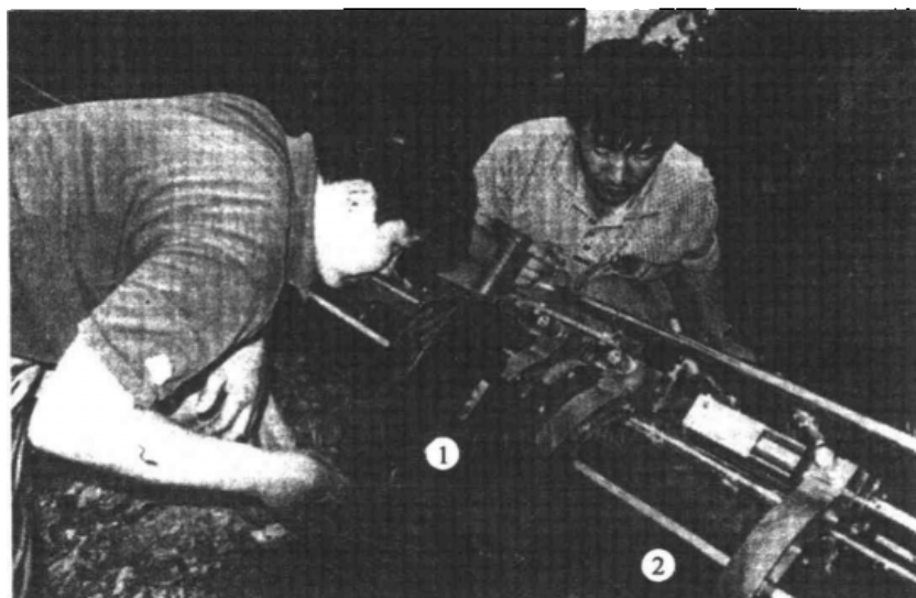
热熔对接连接操作现场
